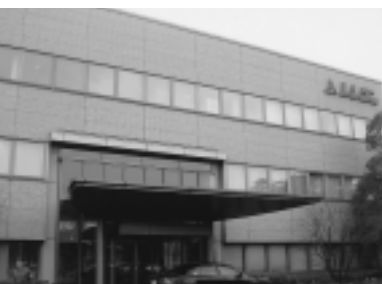
レンゴー東京工場
