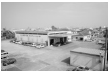
本社、熊谷物流センター
