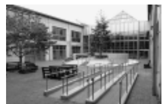
行田市総合福祉会館やすらぎの里 中庭改修整備事業
